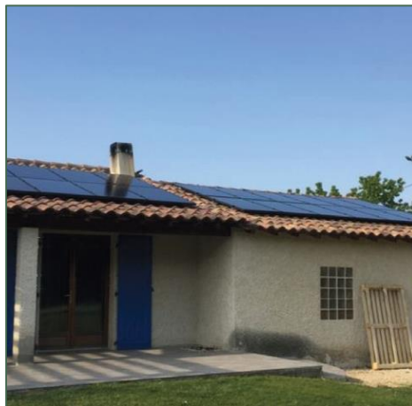
Photo d'une installation en surimposition à éviter (source : préfecture des Haut-Pyrénées)
