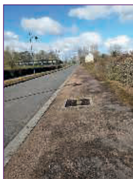
Avenue de la gare Revégétalisation
